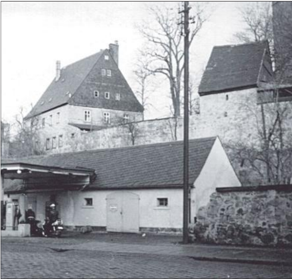
Abb. 177 Ehemalige Knabenschule (Kirchgemeindehaus), Kirchhofsmauer und Speicher 1 von Süden, um 1960.
